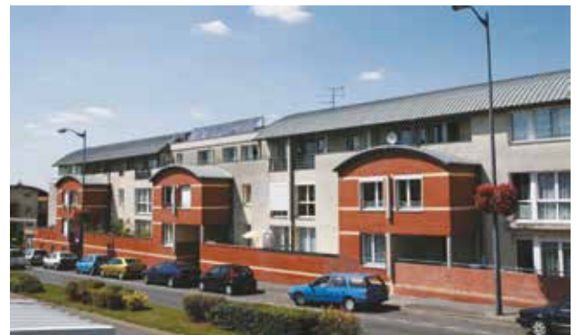
Dans cet immeuble de Saint-Quentin (Picardie), l'eau chaude est produite grâce à des panneaux solaires.
